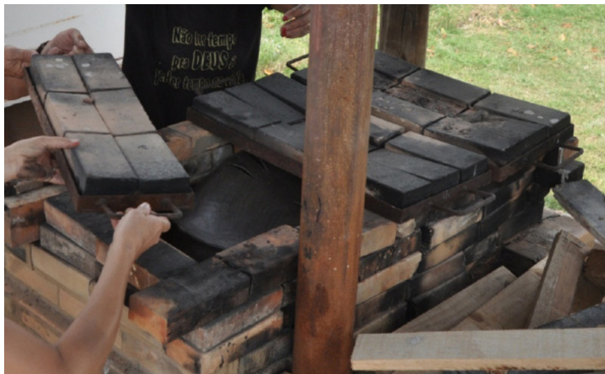
Figura 15 – São colocadas quatro placas de metal com tijolos por cima para cobrir totalmente o forno.
