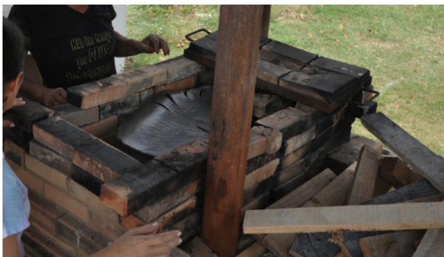
Figura 14 - Após a organização do forno, ele começa a ser tampado.
