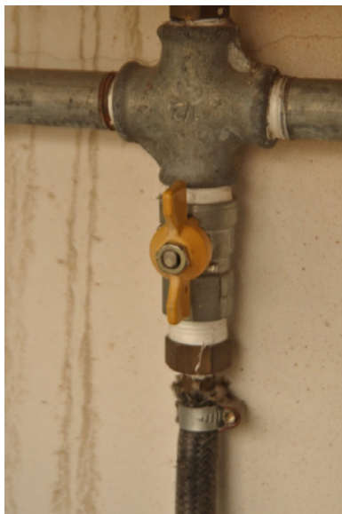
Figura 5 - Válvula para liberação de gás do cilindro.
