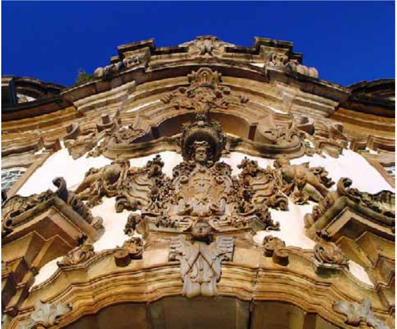
Frontispício da Igreja do Carmo - riqueza de detalhes e a harmonia entre o quartzito e a pedra-sabão
