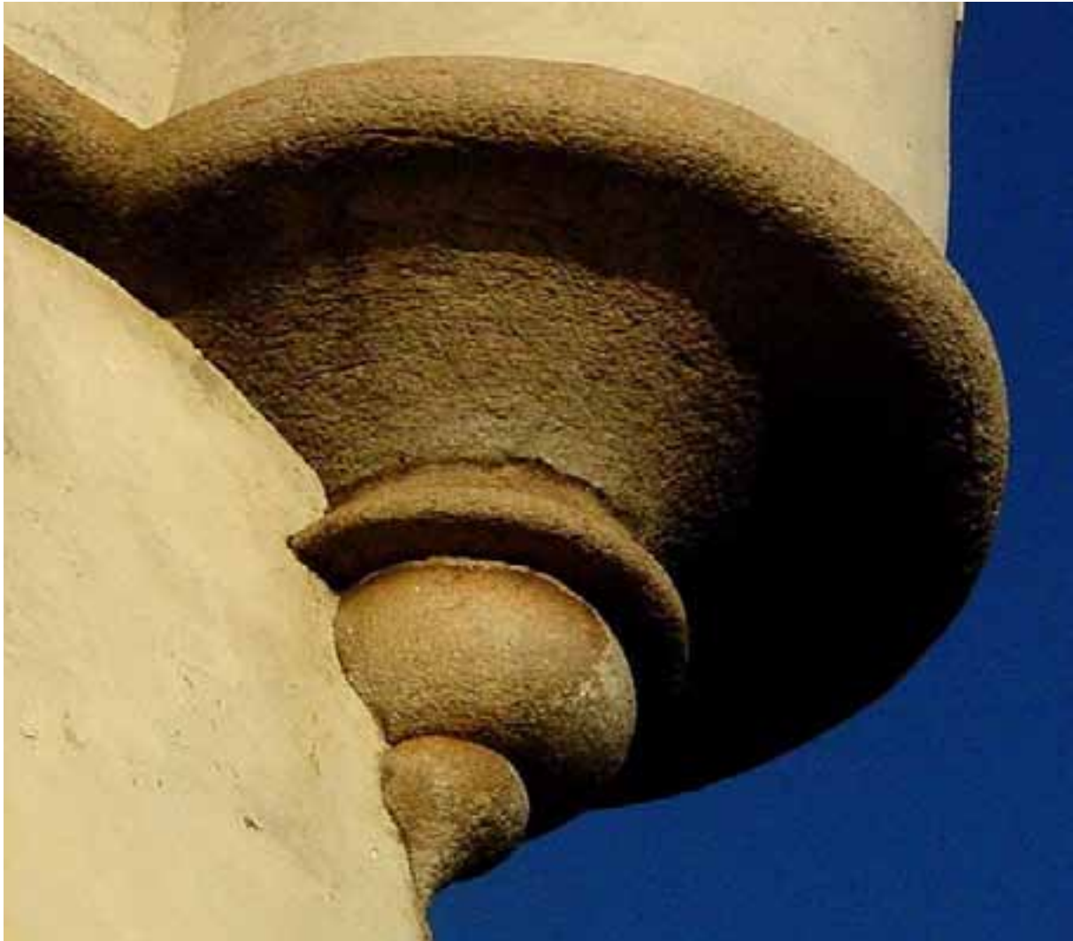
Base de Cantaria em granito em Parati, Rio de Janeiro
