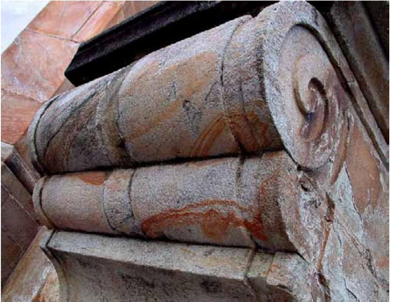
Detalhe da cantaria da Igreja do Pilar, com volutas e frisos na base das colunas
