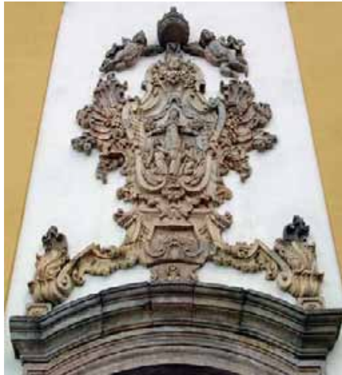
Capela de Nossa Senhora das Mercês - Medalhão de pedra-sabão e portada de quartzito
