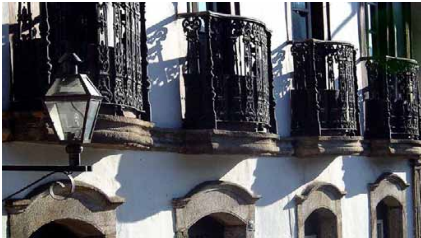
Casa dos Contos, fachada na rua direita com detalhes de Cantaria de quartzito
