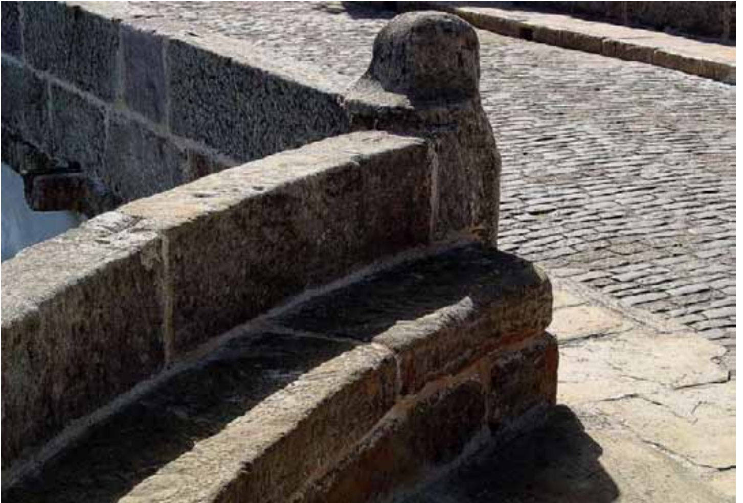
Detalhe dos bancos de quartzito da Ponte de Marília após restauração
