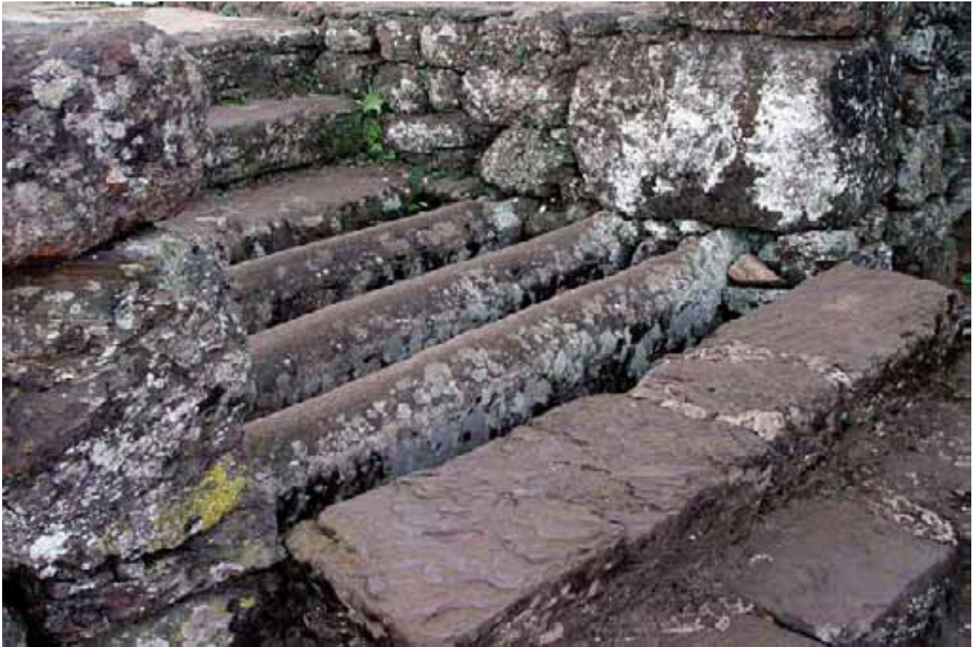
Detalhe do Mata Cavalo, Capela de Santana - este sistema era usado nas capelas mais antigas para evitar a entrada de cavalo na igreja
