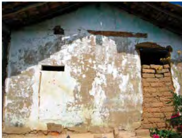
Parede de adobe pintada com tinta de barro branco
