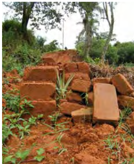
Pilha de tijolos de adobe em deterioração
