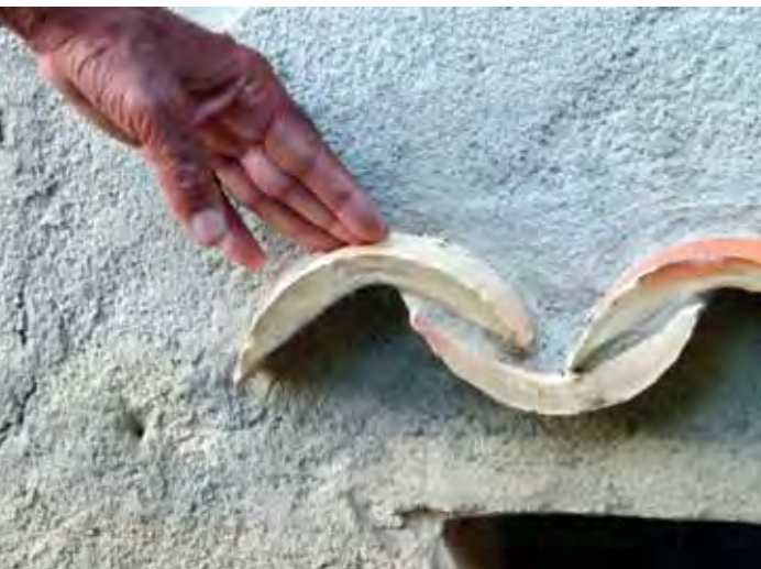
Detalhe de pingueira construída por mestre Aleixo em Santa Luzia
