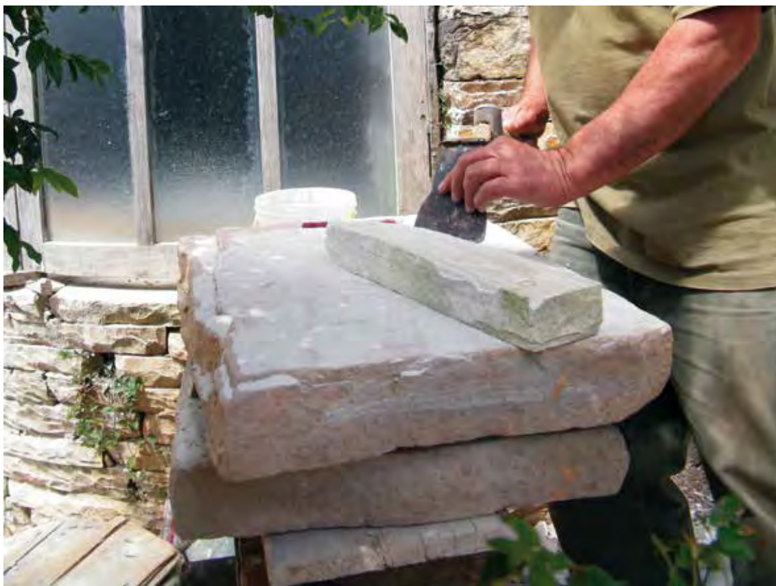
Preparação da pedra com corte manual
