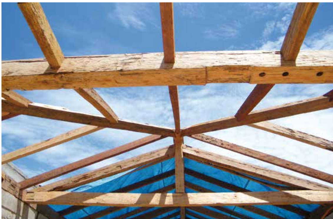
Detalhe aproximado do encaixe de espigão em cumeeira e pernas no pontalete
